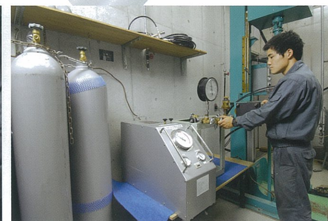
安全弁作動検査
